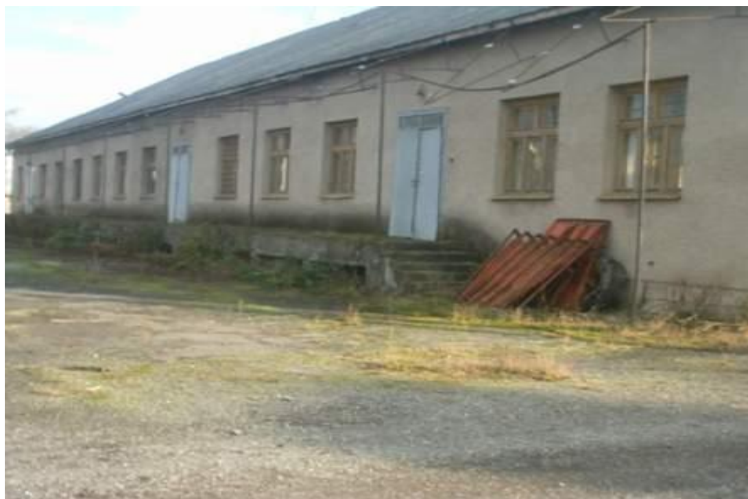
Приміщення консервного цеху.
